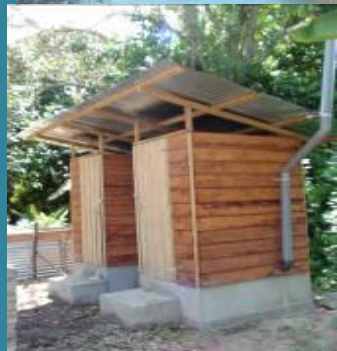
Inodoros de Desviación de Orina – Proyecto piloto del PAN de Surinam
